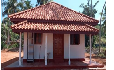
கடாவெட்டுவா மேட்டு துண்போதியா பெளத்த ஆலய புனரமைப்பு செயற்பாடுகள், தேவேந்திர முனை ஒதுக்கீடு - ரூ..500,000.00 செலவினம் .475,267.96
